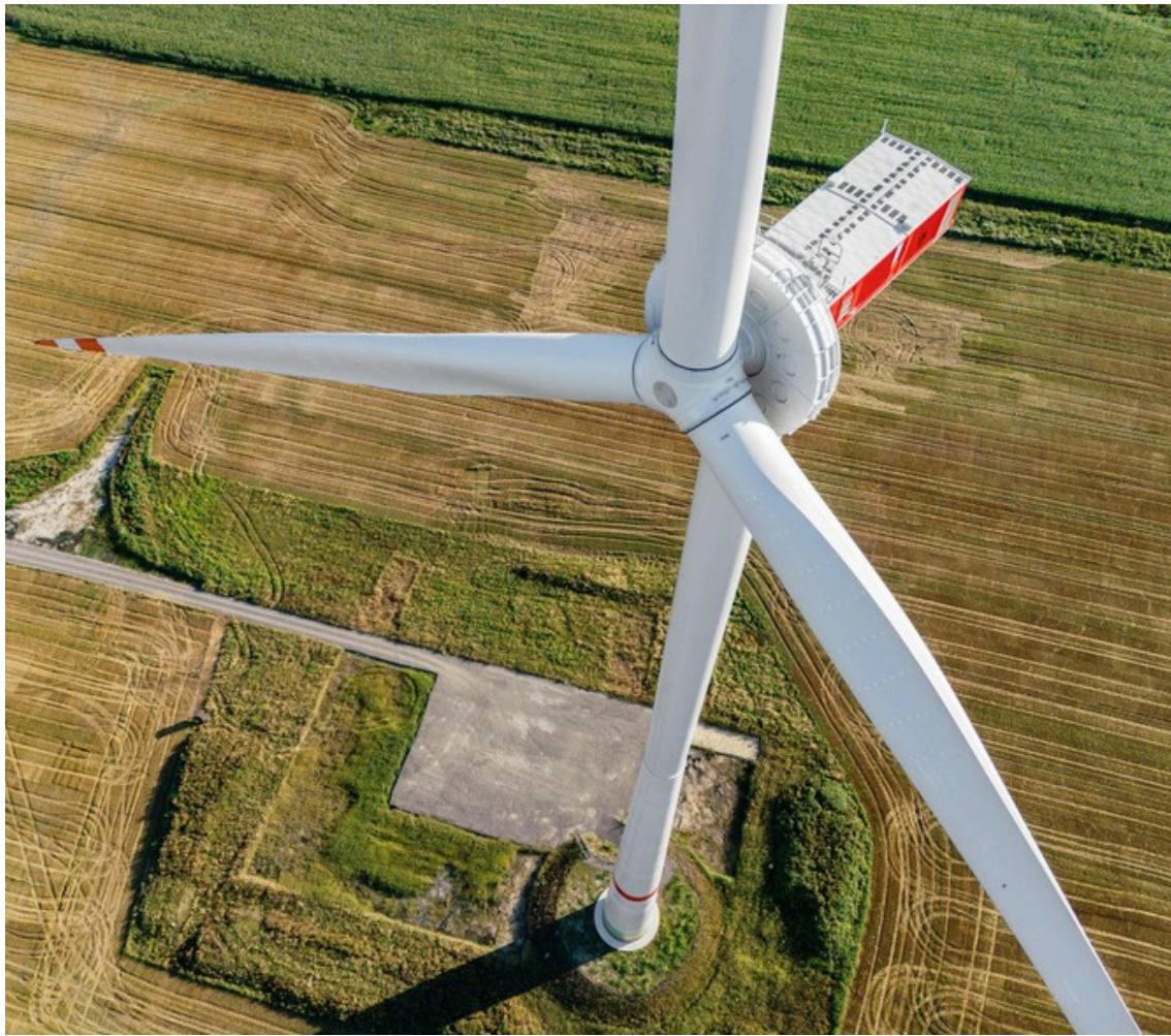
© FOTO: ENERCON GMBH 2026
